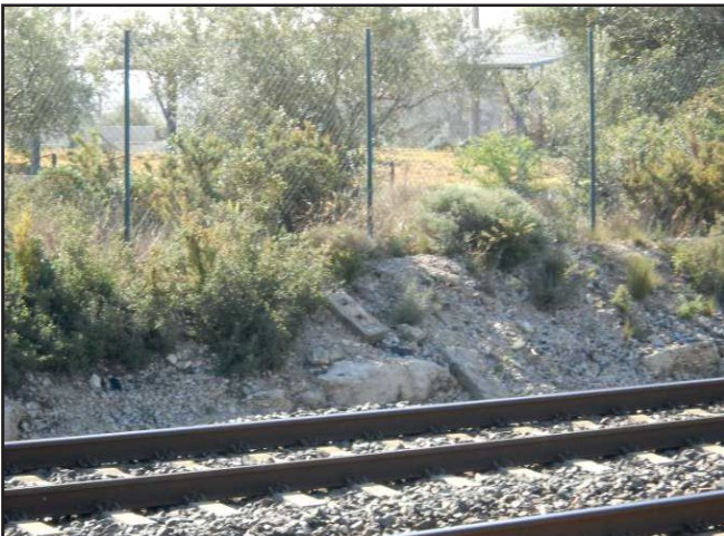
Material a la zona de vies.
