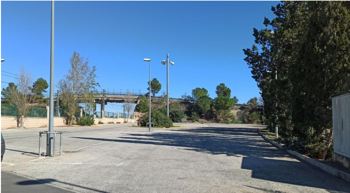
Il·lustració 11. Aparcament municipal final Av. Sant Joan.
