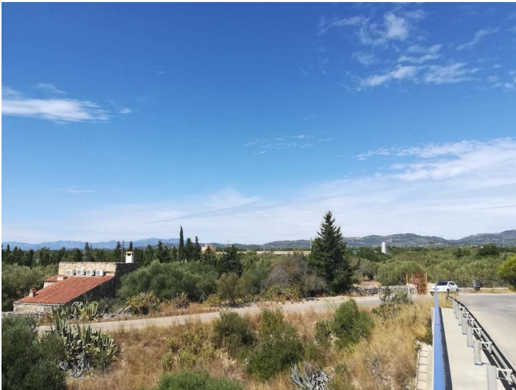
Vista de l'explotació des del pont que creua l'AP-7 amb la nau antiga en primer terme, i que tapa la nau executada al 2.013 (darrera).
